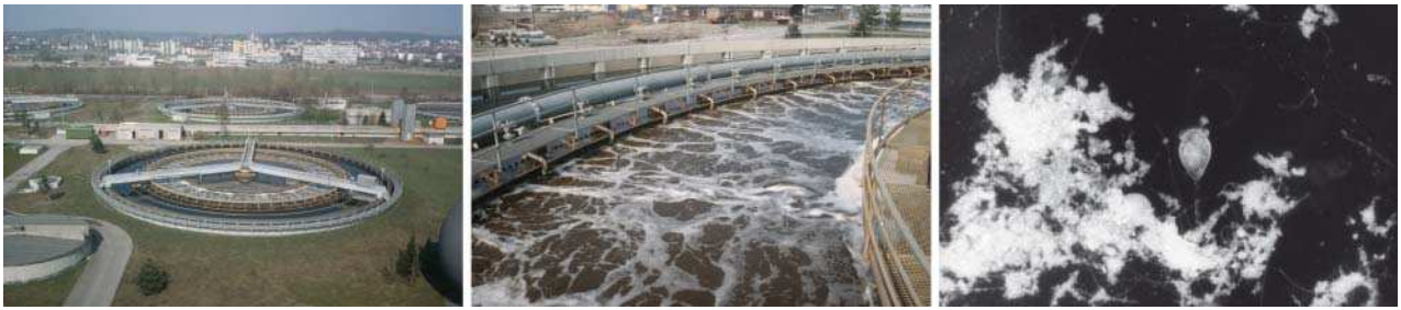
Abb. 19.24 Belebtschlammbecken der Zentralkläranlage Konstanz. a Übersicht. Das Wasser wird radial von innen nach außen transportiert, die Belüftung erfolgt im mittleren Ring. b Belüftungsbecken. c Belebtschlammflocken bei schwacher Vergrößerung im Dunkelfeldmikroskop (Aufnahmen B. Schink, Konstanz).
