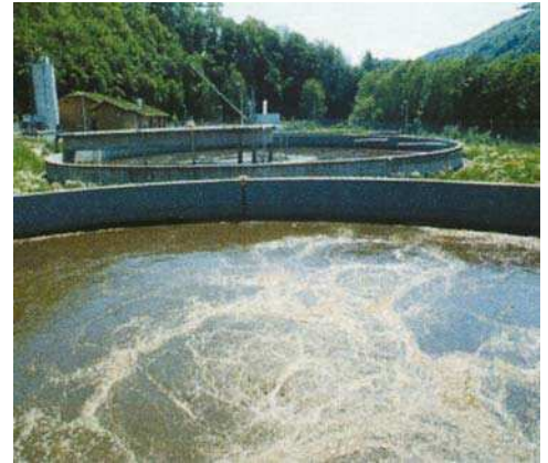
Abb. 1.14 Biologische Abwasserreinigung in einer Kläranlage (Aufnahme Lenntech, Wasser- und Luftbehandlung, Delft).
