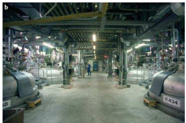
Abb. 19.2 Fermenteranlagen zur Produktion von Biomasse oder Reaktionsprodukten. a Schema eines Laborfermenters. b Große technische Fermentationsanlage, zu sehen sind nur die Deckel der Fermenter, die jeweils ein Arbeitsvolumen von 100 m 3 haben (Aufnahme Fa. BASF, Ludwigshafen).
